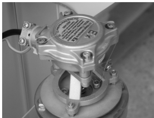
Рисунок В.1 – Схема пломбировки генератора импульсов, производства фирмы «Zhejiang Datian Machine Co., Ltd.» с измерителем объема СУГ
